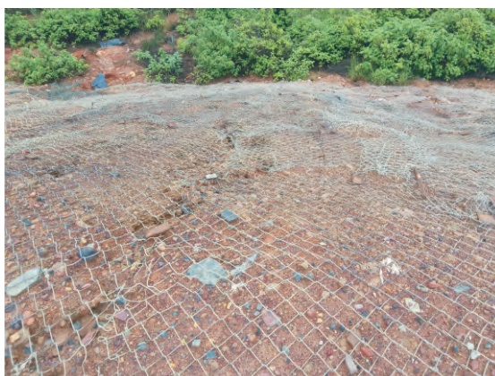
图：尾矿库护坡工程
